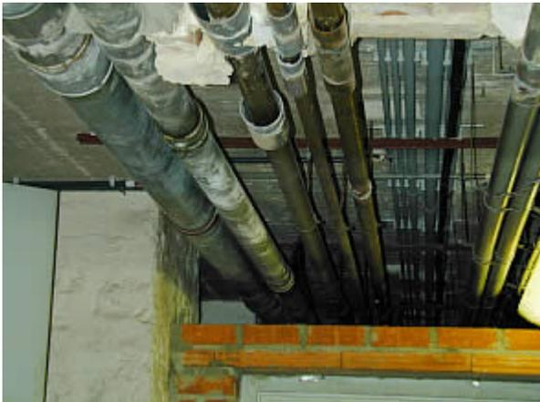
Boucle de distribution d'eau chaude sanitaire non isolée, dans un vide ventilé de 100 m de long !
