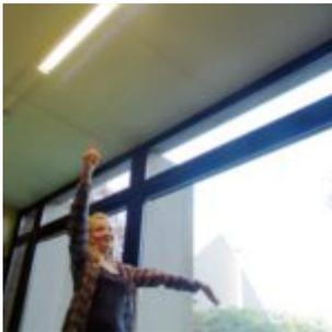
L'éclairage artificiel est bien souvent installé de façon symétrique, avec le même nombre de lampes du côté fenêtres qu'à l'opposé de celles-ci ! Or la classe n'étant utilisée qu'en journée, la luminosité naturelle est suffisante le long des fenêtres. A défaut d'interrupteur de rangées, il est souvent possible de dévisser un tube sur deux le long des fenêtres.
